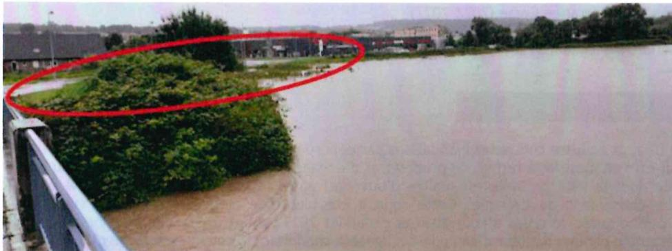
**Figure ci-dessus :** zone d'expansion des crues des Brétilloux submergée et début d'inondation du boulevard de la Liberté à Delle (crue de juillet 2021)
