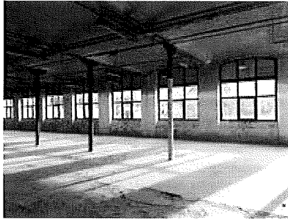
Vue intérieure façade sud
