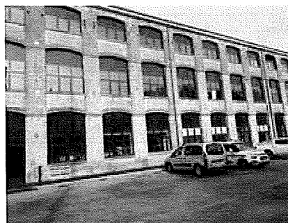
Vue extérieure façade sud
