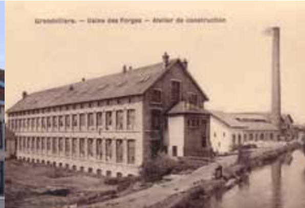
Le bâtiment des Forges dans le passé
