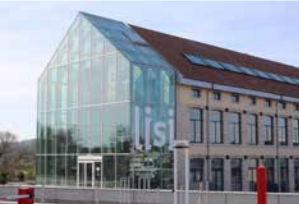
Le bâtiment des Forges réhabilité
