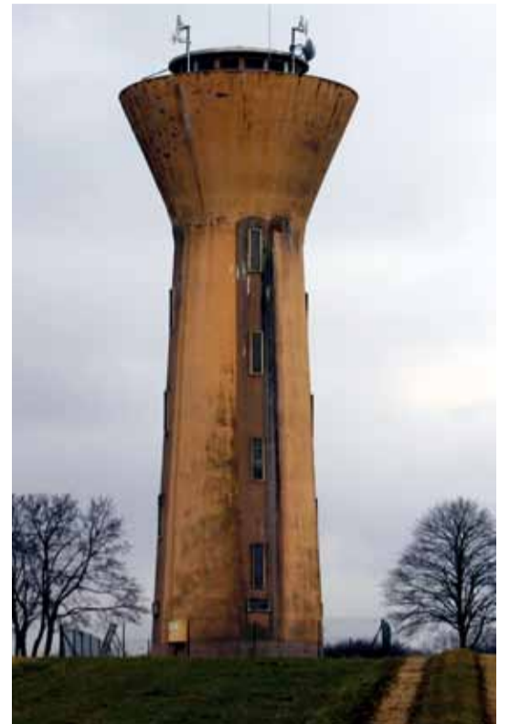
Les antennes WifiMax au sommet du château d'eau de Chavannes-les-Grands.
