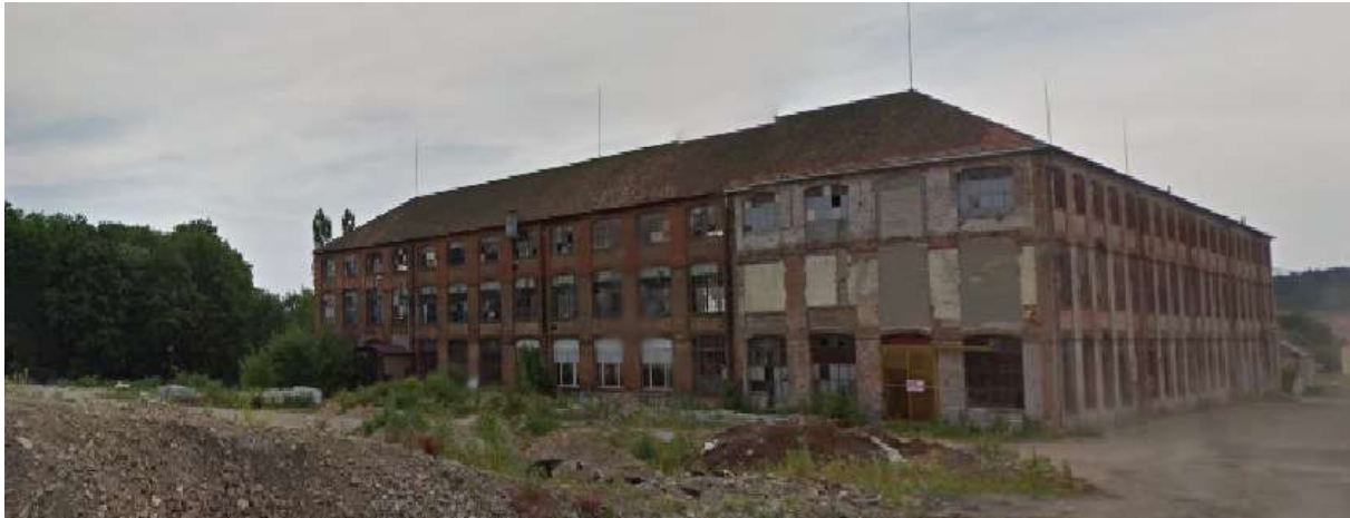
Le bâtiment porte les marques des adjonctions successives, aujourd'hui déconstruites
