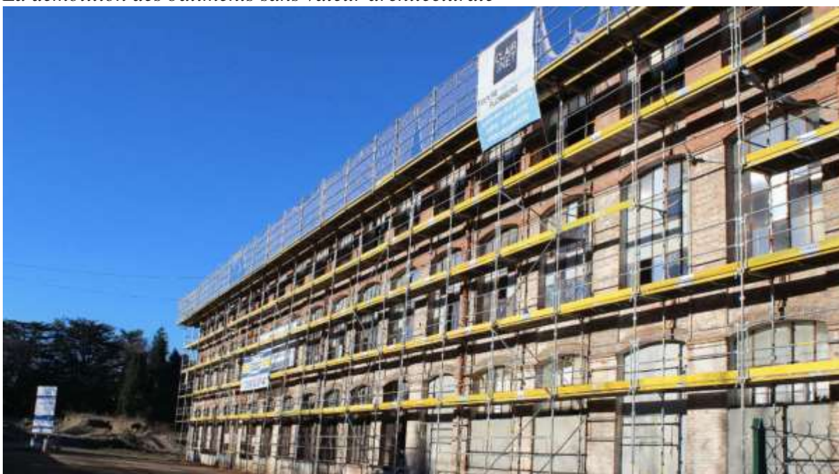
La rénovation des toitures
