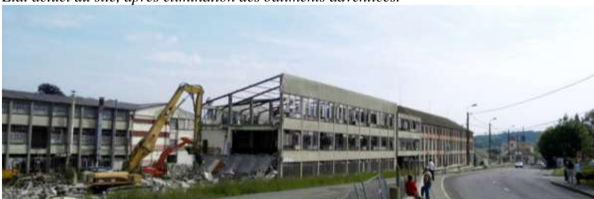
La démolition des bâtiments sans valeur architecturale
