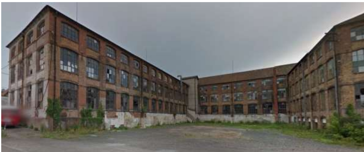
Etat actuel du site, après élimination des bâtiments adventices.
